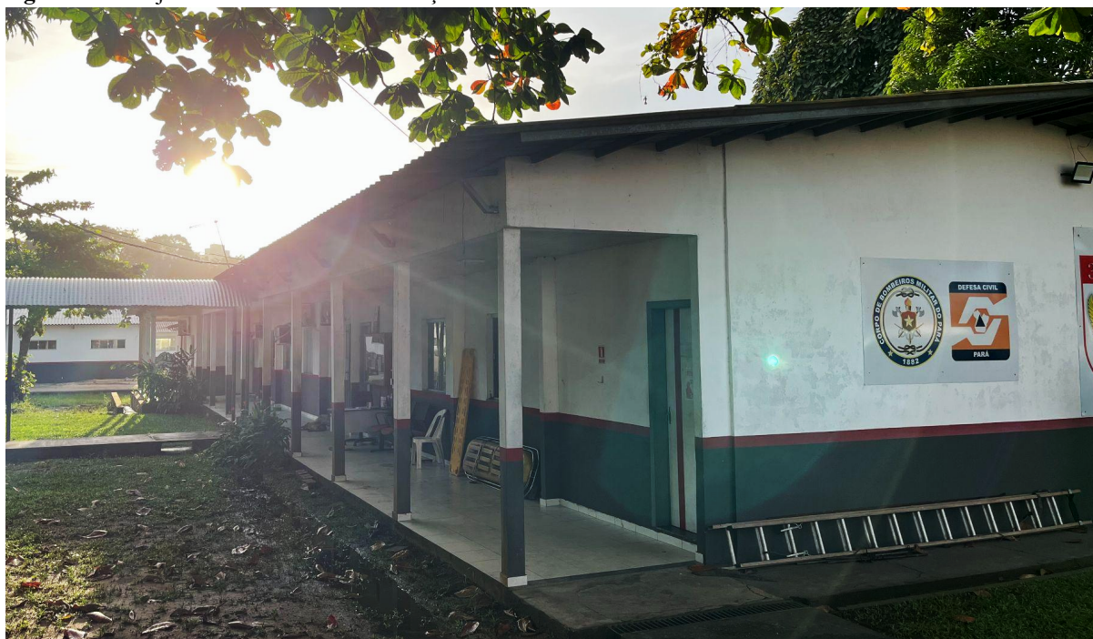
Figura 05: Alojamento do efetivo em serviço ordinário 24h
