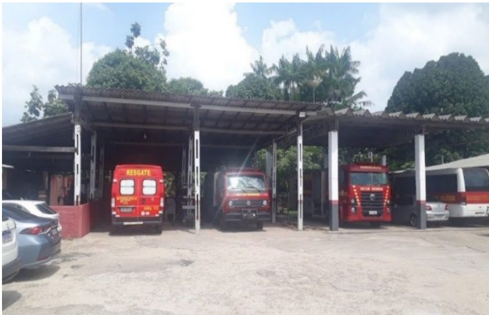
Figura 10 – Estrutura da garagem do Quartel do 26º GBM, em 2024.
