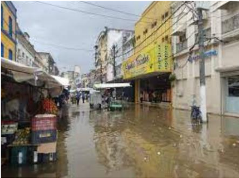
Figura 15: Inundação da Rua João Alfredo em 22mar23
