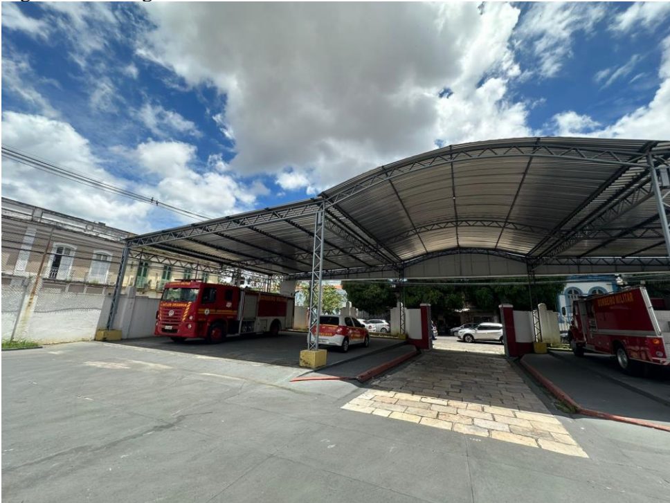
Figura 22: Garagem de Viatura e entrada do 21 ° GBM
