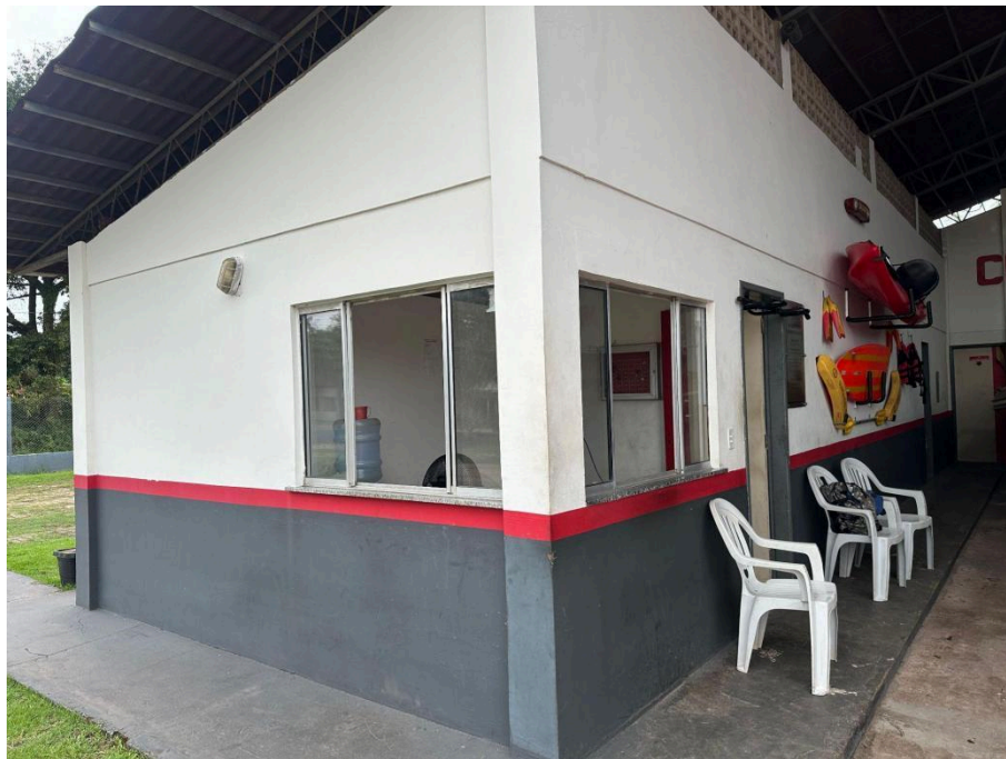
Figura 10- Área de Guarda
