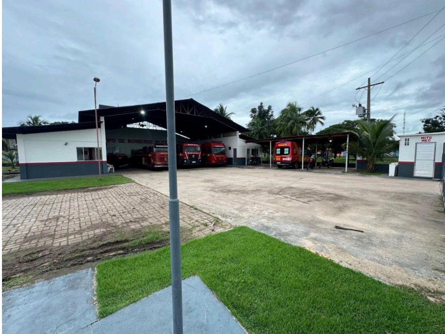
Figura 11 - Vista da Entrada do Quartel
